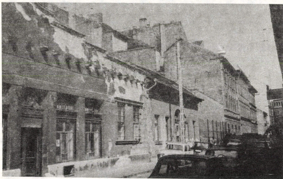
2. kép. A ferencvárosi revitalizáció megjelenése (A) eredeti állapot (B) revitalizált lakófunkciós épületek (Fotó: TÓZSA I.)
