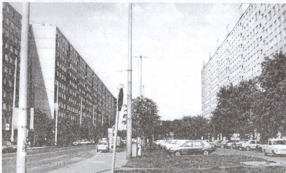
1. kép. Tízemeletes sorházak a debreceni Csapó utcában Ten storeyed residential buildings along the Csapó Street, Debrecen
