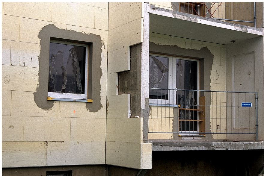
1. kép. Panelépületek külső hőszigetelése és a nyílászárók cseréje
