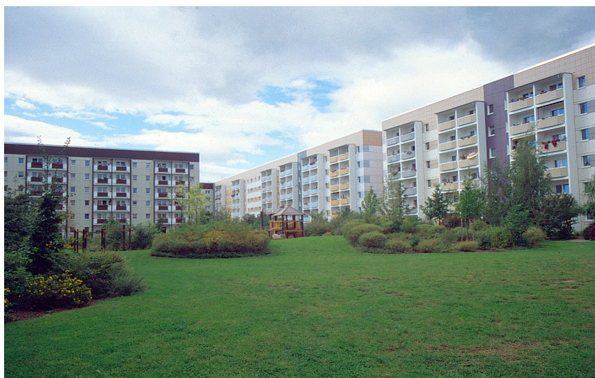
5. kép. Felújított panelépületek zöldterületi rehabilitációval, Lipcse-Grünau városrészéből. (A képek szerző felvételei)
