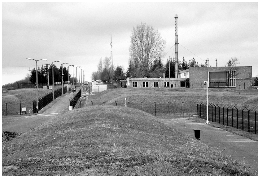
1. kép. A püspökszilágyi RHFT telephelye General view of the nuclear waste disposal site (RHFT) at Püspökszilágy
