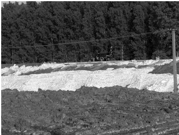
3. kép. Árvédelmi töltés 6 m-es rézsűcsúszása Szelevény és Csongrád között a 2006-os tavaszi árvíz idején
