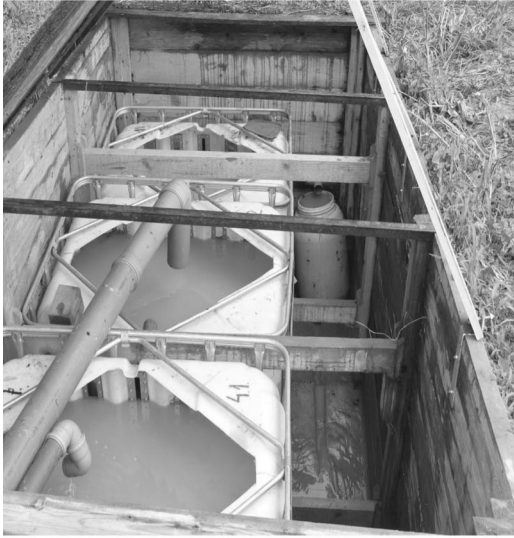
1. kép. A lefolyó vizet összegyűjtő tartályok és az elosztómű Runoff collecting tanks and the diffuser
