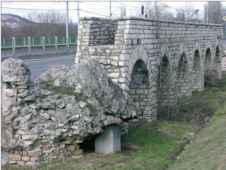
4. kép. A polgárvárost és a katonavárost ellátó római kori vízvezeték ( aqueductus ) maradványai és helyreállított rövid szakasza. (Fotó: POÓR I.)
