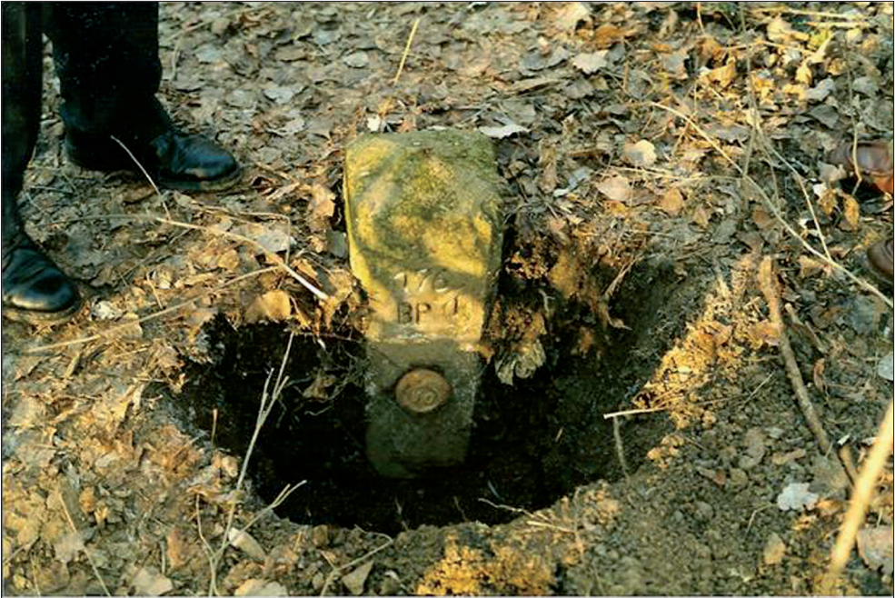
8. kép. Feltöltött hullámtérbe süllyedt ún. V.O. kő Rákóczifalvánál. (Fotó: BALOGH J. 2002.) (A V.O. kövek a főbb folyók partján egymástól 2–3 km-re kijelölt nyilvántartási szelvények végpontjain a mederfelvételek céljából elhelyezett vízszintes és függőleges értelmű geodéziai alappontok. Nevüket onnan kapták, hogy az 1890-es években folyóink térképezésekor az egykori Vízrajzi Osztály helyezte el őket.)
