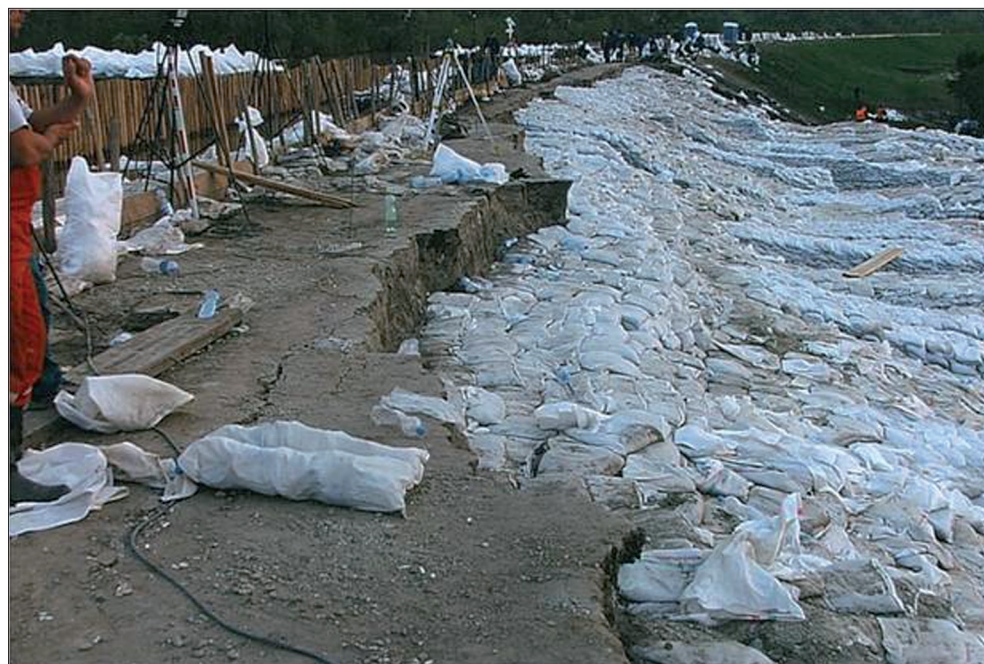
15. kép. 2006-ban Szelevény mellett a Tiszazugban katasztrófa közeli rézsúcsúszás alakult ki, amit a Katasztrófavédelem irányításával a helyi lakosság emberfeletti munkával hártott el. (Fotó: SCHWEITZER F.)
