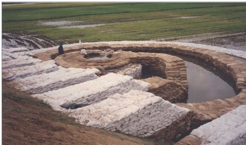
13. kép. Közép-Európa legnagyobb buzgárja Tiszasasznál 2000 áprilisában. A buzgár a Tisza bal partján a mentett oldalon, a töltés lábától 4 m-re alakult ki. (Fotó: KÖTIVIZIG)
