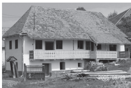
2. kép. Énlaka egyik lakatlanná váló házána felújítása és átalakítása vendégházzá
