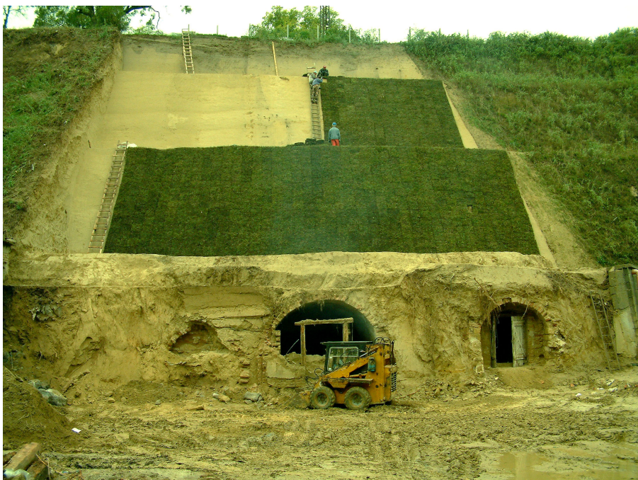
3. ábra. A dunakömlödi magaspart-rehabilitáció kivitelezési munkái (Fotó: BALOGH J. 2003) Figure 3 Bluff rehabilitation works under way at Dunakömlöd (Photo by BALOGH, J. 2003)
