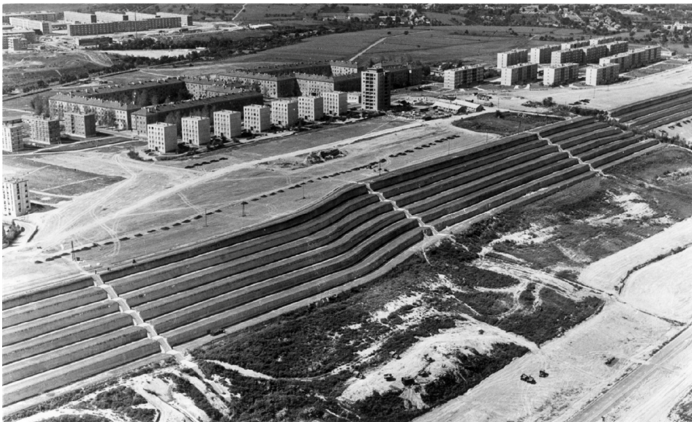
4.ábra. Dunaújvárosi lépcsős magaspárt-védelem az 1950-60-as években (Fotó: KÉZDI Á. 1978)
